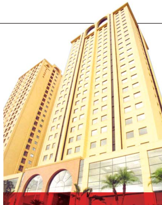
Detalhe da imponência do Metropolitan Business Center: segurança garantida com a energia da Cummins.
